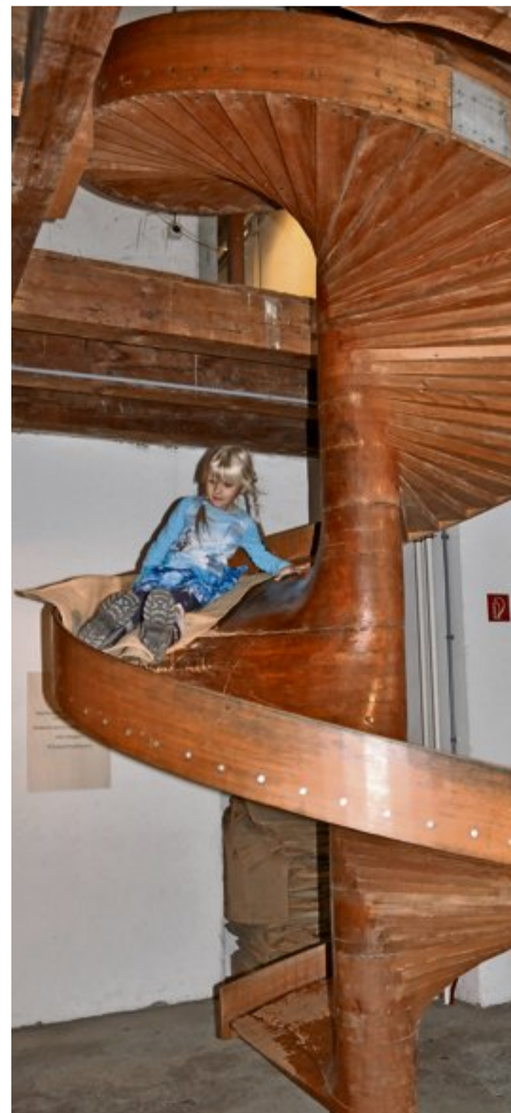
Ist das Mehl fertig, wird es in Säcke abgefüllt und die Sackrutsche hinuntergeschickt. Im Mühlerama dürfen auch die Besucher runterrutschen.
